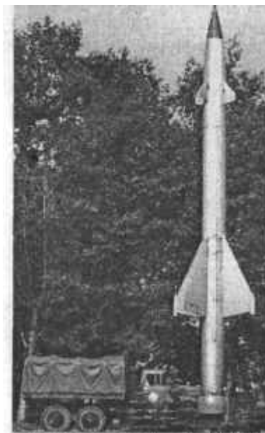
Стационарная пусковая установка С-25 с вертикальным стартом
